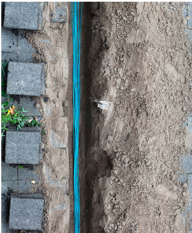
□ BEELD: ONDERGRONDSE KABELS EN LEIDINGEN(P. DE KIEVITH)
